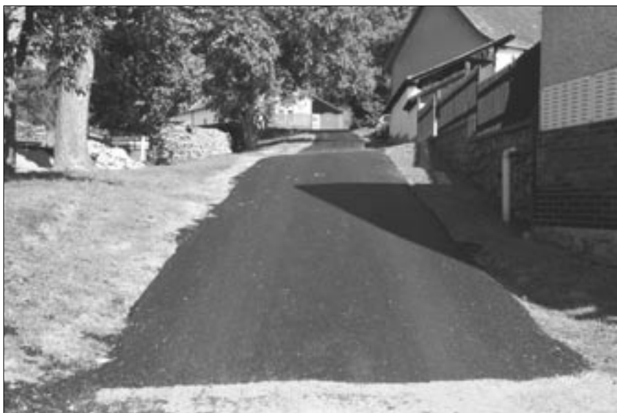
Opravená silnice v Bedřichovicích
