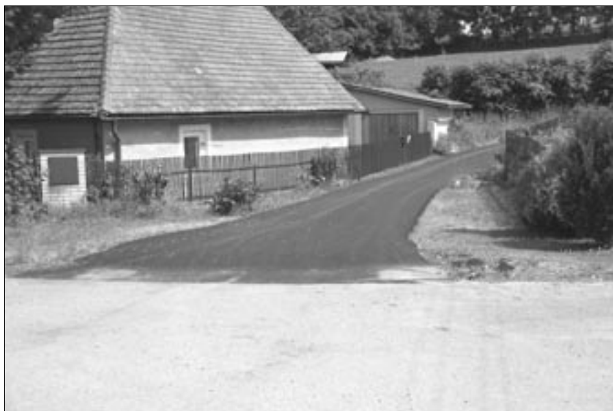
Opravená silnice v Nosákově
