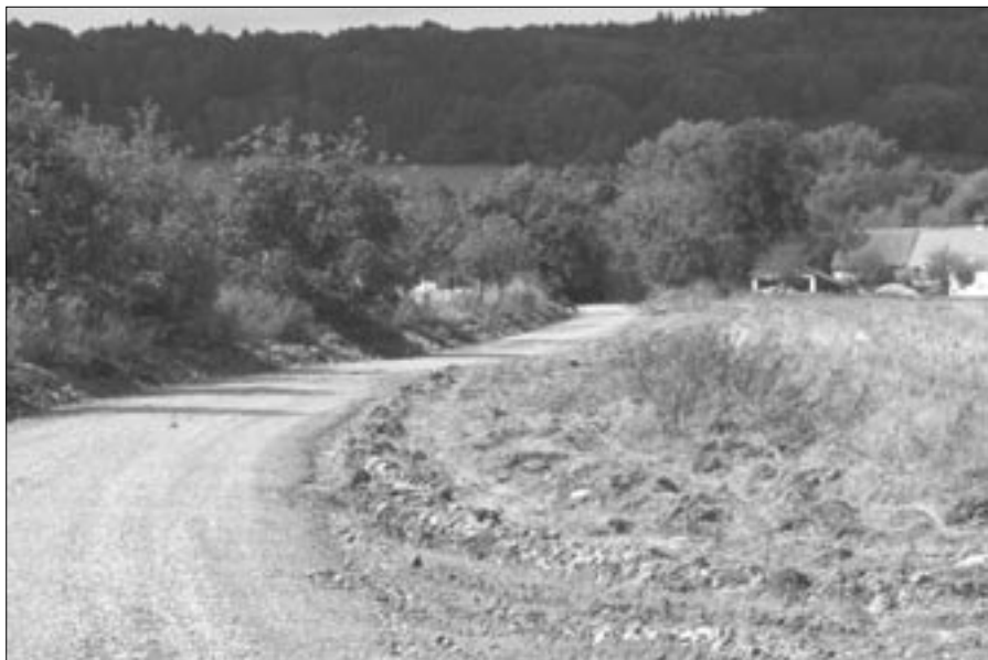
Opravená silnice ke Skřivánku
