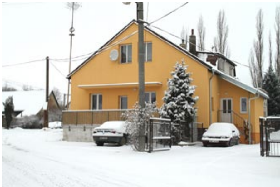
Dům č.p. 7 v Pičíně po rekonstrukci
