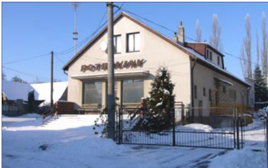
Dům č.p. 7 v Pičíně - bývalá prodejna - před rekonstrukcí
